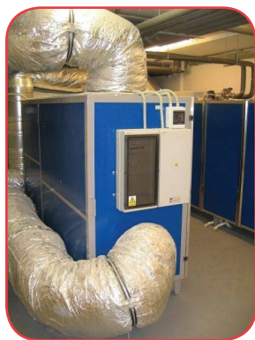
Obr. 6. Centrum Veronica v Hostětíně bylo postaveno v roce 2006 jako první česká veřejná budova splňující pasivní standard. Jeho součástí je i větrací systém se zpětným získáváním tepla (rekuperací). Zdroj: http://hostetin.veronica.cz/
