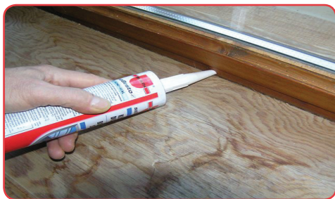
Obr. 5. Izolační pásky jsou levné a jednoduché řešení ke zvýšení těsnosti oken a dveří. Aplikace akrylátového tmele na okenní rám. Zdroj: © e.u.[z.]
