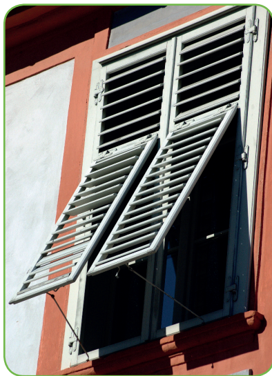
Obr. 8. Vnější stínící zařízení umožňují regulovat vstup tepla do domu.
