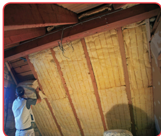
Obr. 9. Dodatečná izolace střechy sníží výrazně tepelné ztráty domu. Zdroj: © Rainer Sturm | PIXELIO.
