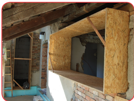
Obr. 4. Předsazení oken do vrstvy izolace (30 cm).
