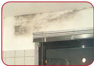
Obr. 3. Viditelný tepelný most způsobený nedostatečnou izolací překladu nad oknem, který vede až k tvorbě plísní. Zdroj: © Wilfried Walter
