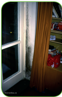
Obr. 3. Snížená možnost pohybu vzduchu či tepelné mosty vedou ke vzniku plísní. Zdroj: www.stavarina.cz .
