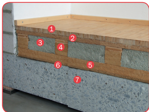
Obr. 8. Příklad zateplení podlahy nad sklepem.
