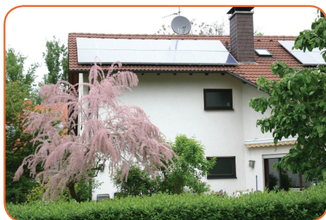
Obr. 3. Standardní umístění solárních panelů na jižní straně domu. V tomto případě využívají majitelé sluneční energii jak pro ohřev vody, tak i na přitápění. Zdroj: Nazeleno.cz
