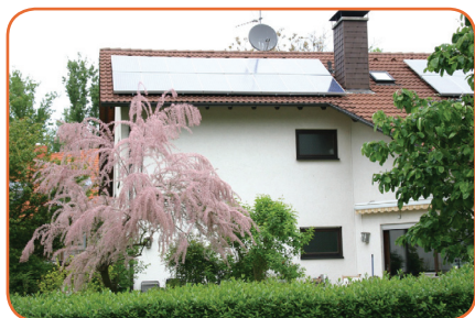
Obr. 5. Standardní umístění solárních panelů na jižní straně domu. V tomto případě využívají majitelé sluneční energii jak pro ohřev vody, tak i na přitápění.
