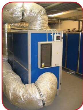
Obr. 5. Centrum Veronica v Hostětíně bylo postaveno v roce 2006 jako první česká veřejná budova splňující pasivní standard. Jeho součástí je i větrací systém se zpětným získáváním tepla (rekuperací). Zdroj: http://hostetin.veronica.cz/
