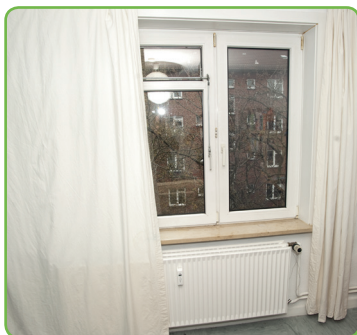
Obr. 1. Udržujte prostor kolem radiátorů volný – nábytek nebo závěsy brání šíření tepla. Zdroj: © Philipp Engewald
